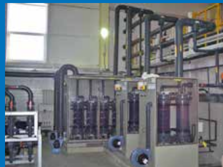
Instal·lació en edifici d'obra civil
